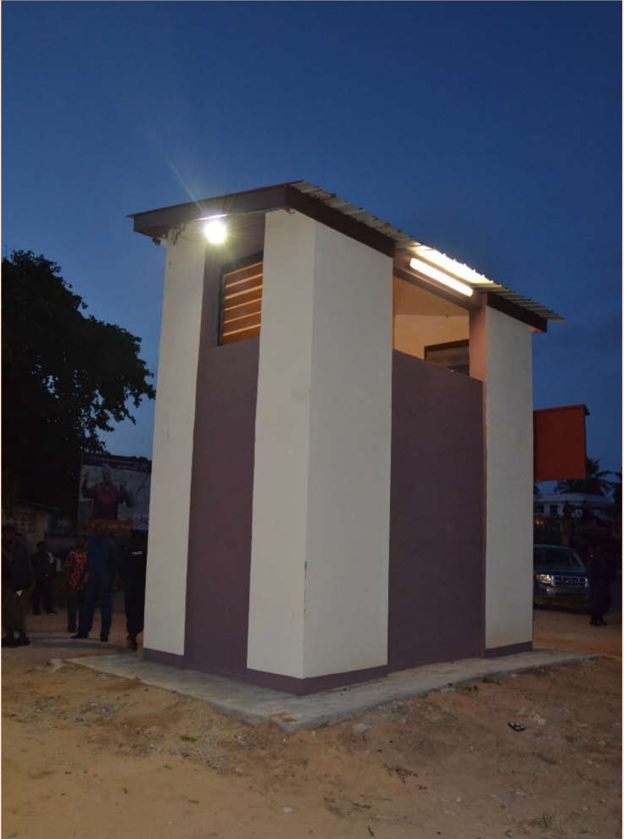
Le Beach Man Hole, le point de rencontre où le câble sous-marin à fibre optique du consortium WACS rencontre celui sous-terrain à fibre optique construit par le Chinois CITCC. Tout achevé. Sauf à planter du gazon et à ériger un jardin de fleurs en vue de stabiliser le sol, on attend que l'ouverture. LE SOFT NUMÉRIQUE-DE PAULIN.
